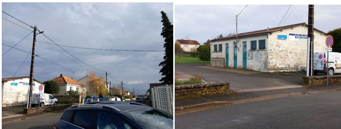
Anciens vestiaires face à l'emprise du stade
